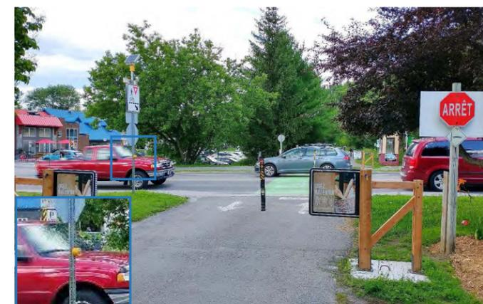
Figure 2.28 Positionnement inadéquat du panneau d'arrêt et du bouton-poussoir Source : Ville de Prévost (2021)
